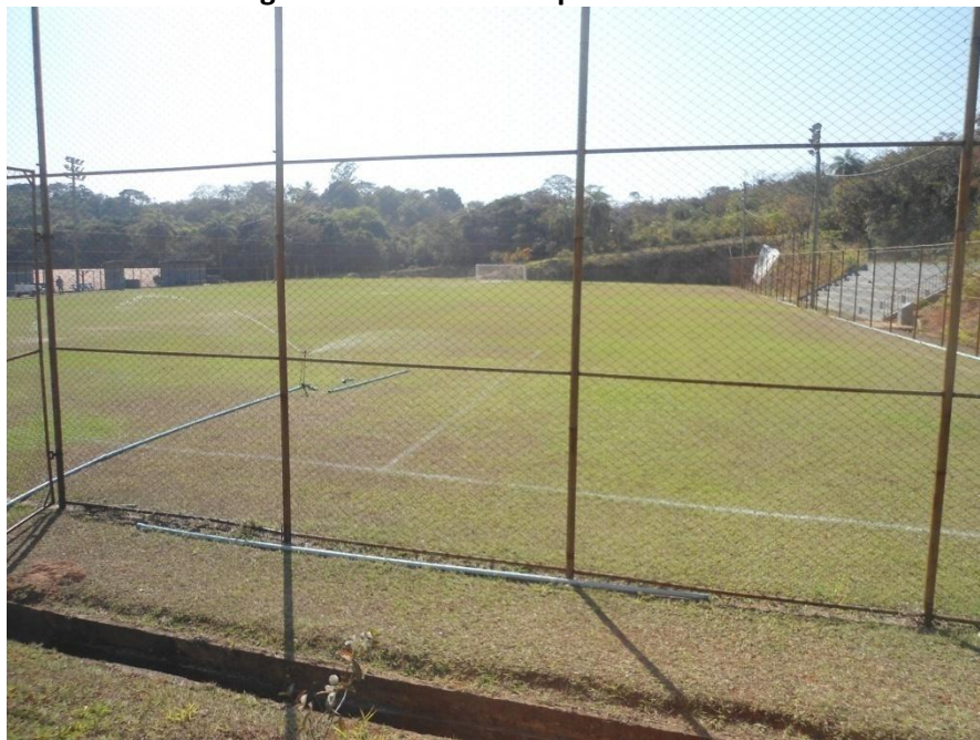
Figura 12: Reforma campo 2 - Durante
