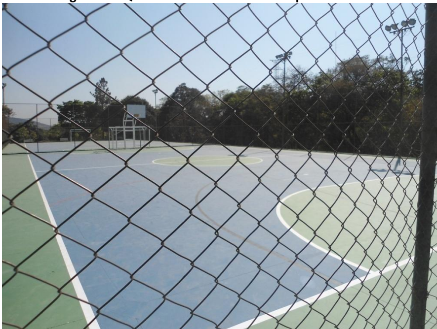
Figura 14: Quadras futebol de salão – Após a reforma
