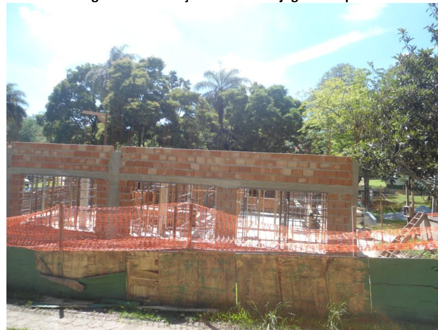
Figura 1: Construção do salão de jogos – Etapa 3
