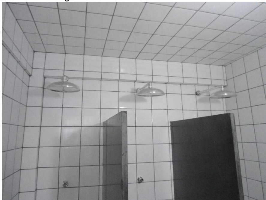
Figura 6: Reforma das Saunas - Vestiários
