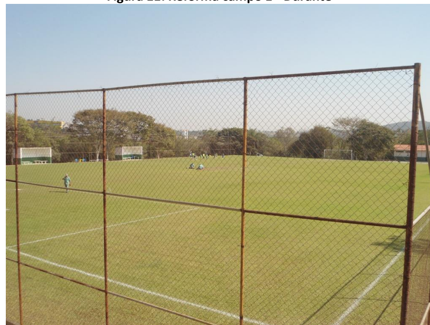
Figura 11: Reforma campo 1 - Durante
