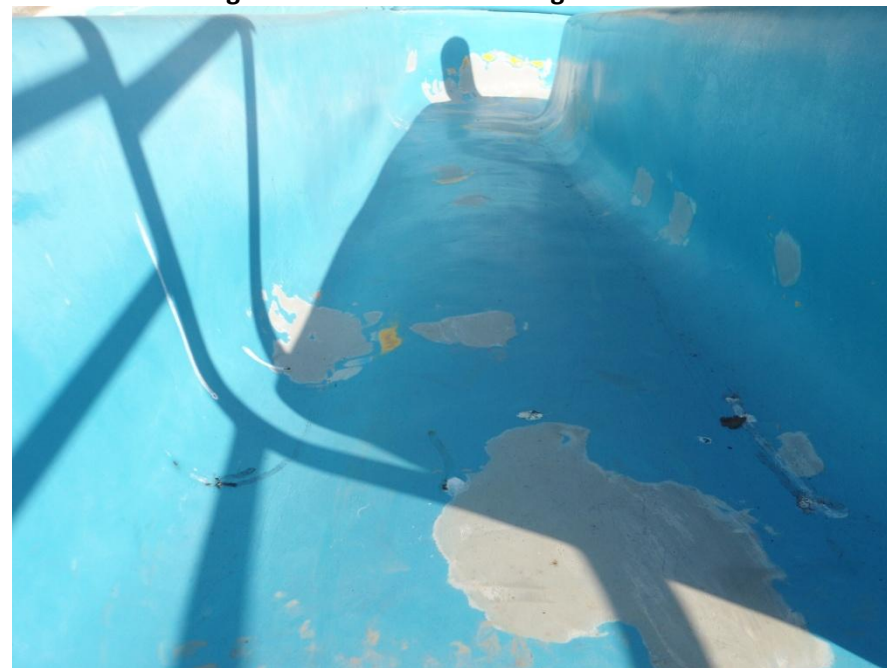
Figura 7: Reforma dos toboáguas - Antes
