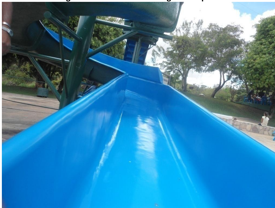
Figura 8: Reforma dos toboáguas - Depois
